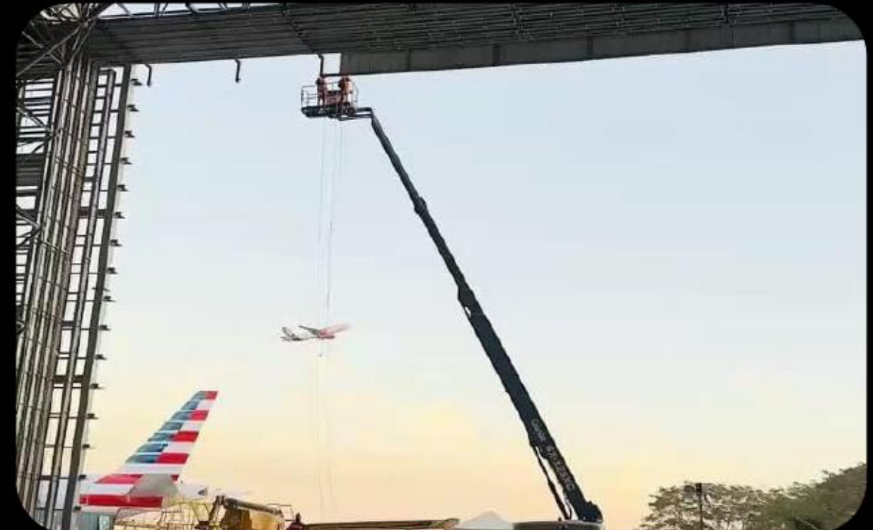
Instalación de sistemas eléctricos para hangar
