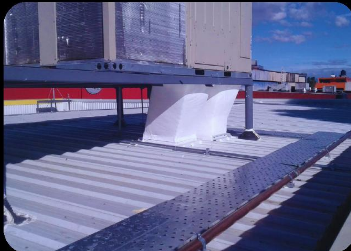
Adecuación de cubierta para instalación de equipos de climatización
