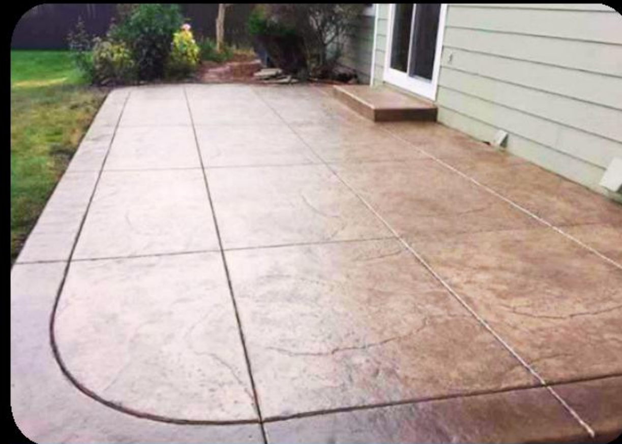
Piso de concreto con acabado estampado en entorno residencial
