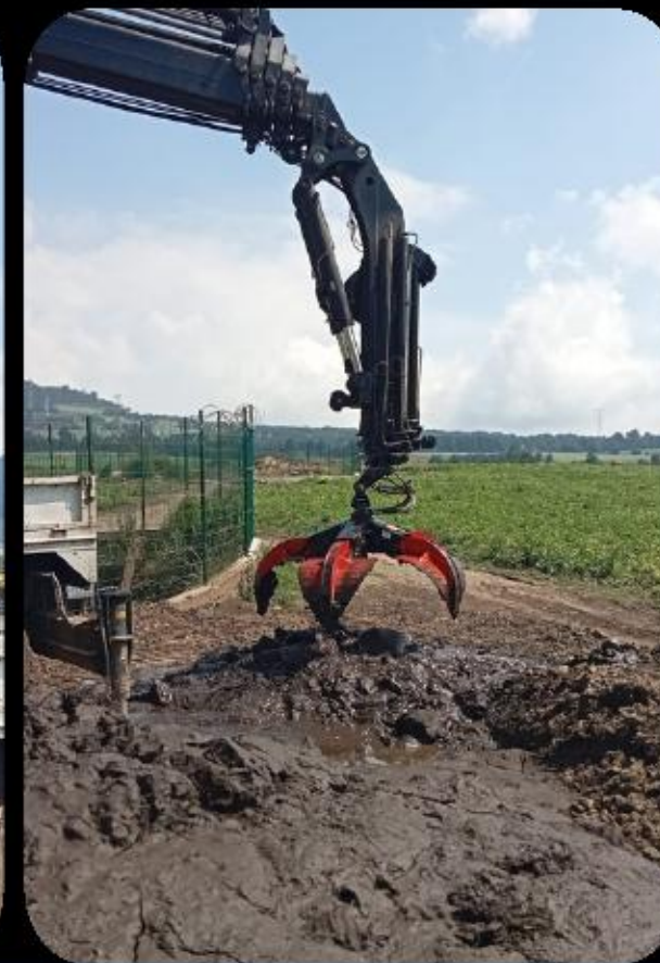
Desazolve y movimiento de material en obra hidráulica
