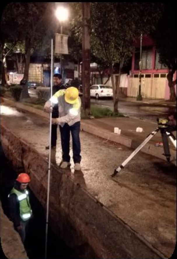
Preparación de zanja con entibado para cambio de atarjea
