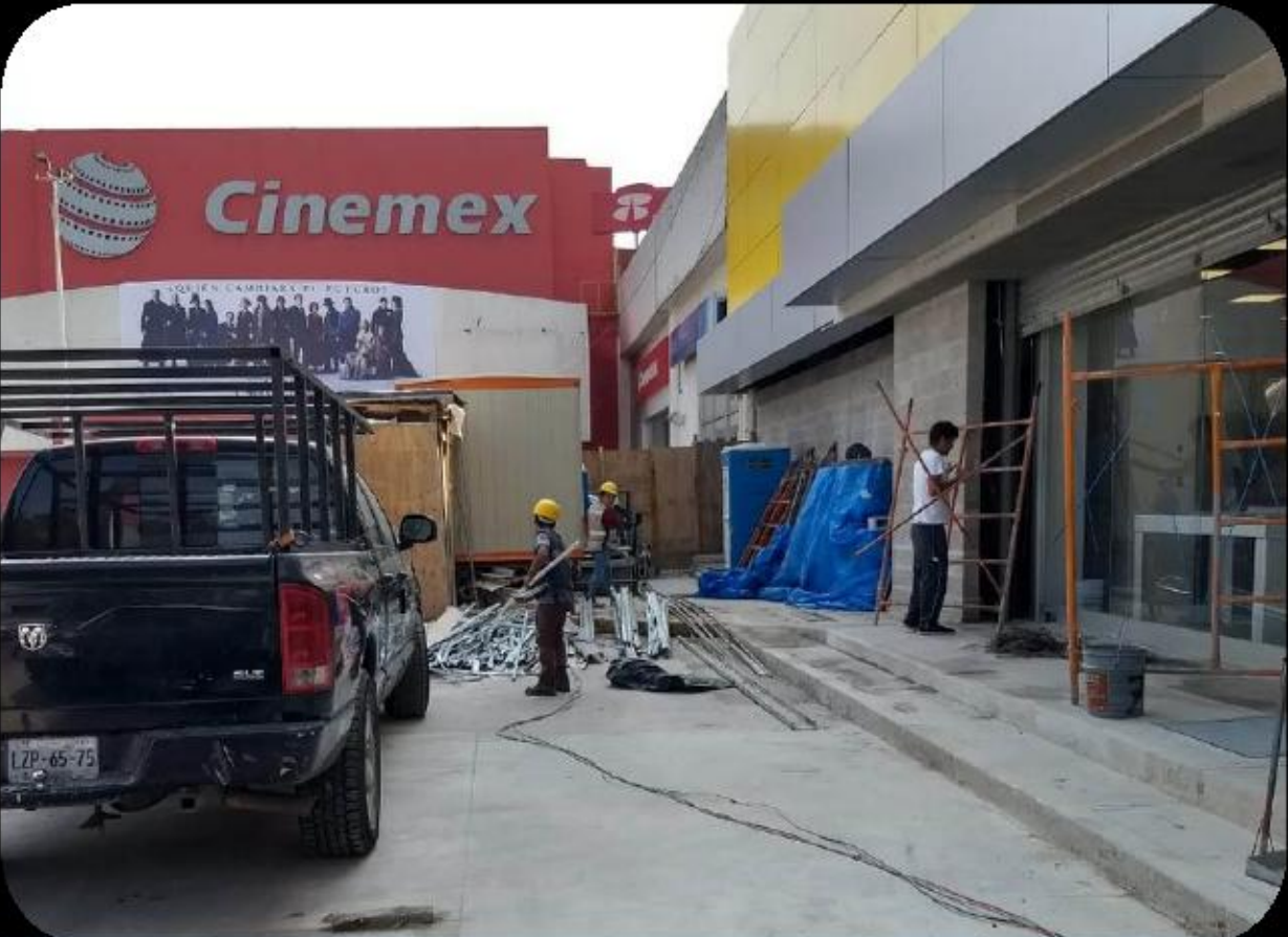
Instalaciones eléctricas e hidráulicas para cinemex y electra
