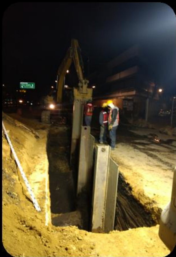
Preparación de zanja con entibado para cambio de atarjea
