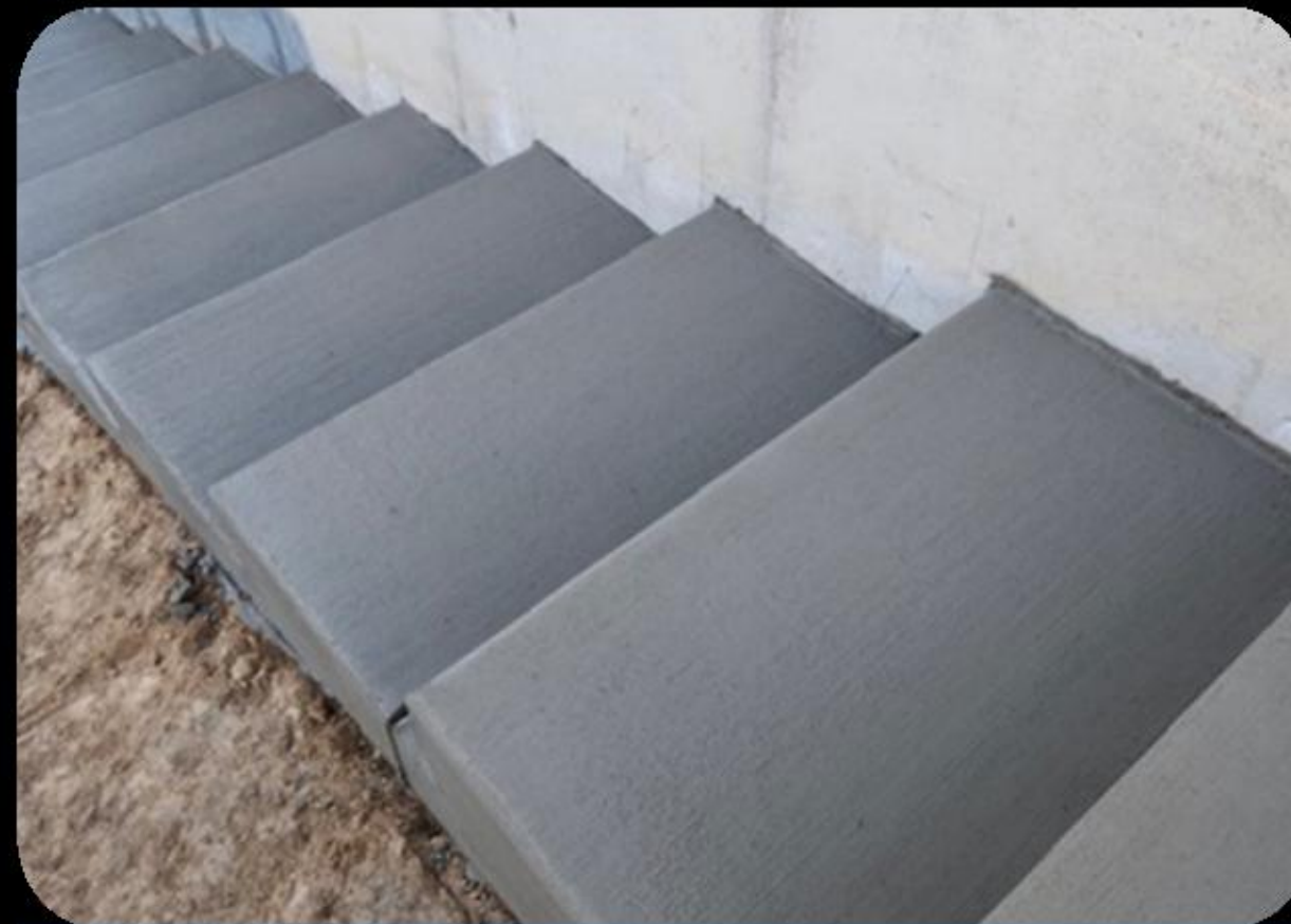
Construcción de escaleras de concreto en sitio
