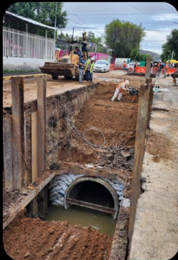
Excavación para instalación de tubería de escurrimientos
