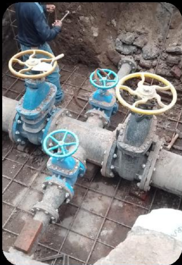
Diseño y ejecución de cruceros de agua potable y agua tratada
