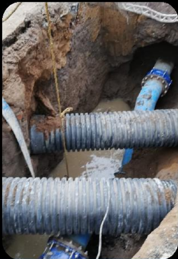
Instalación de bypass para red de agua potable
