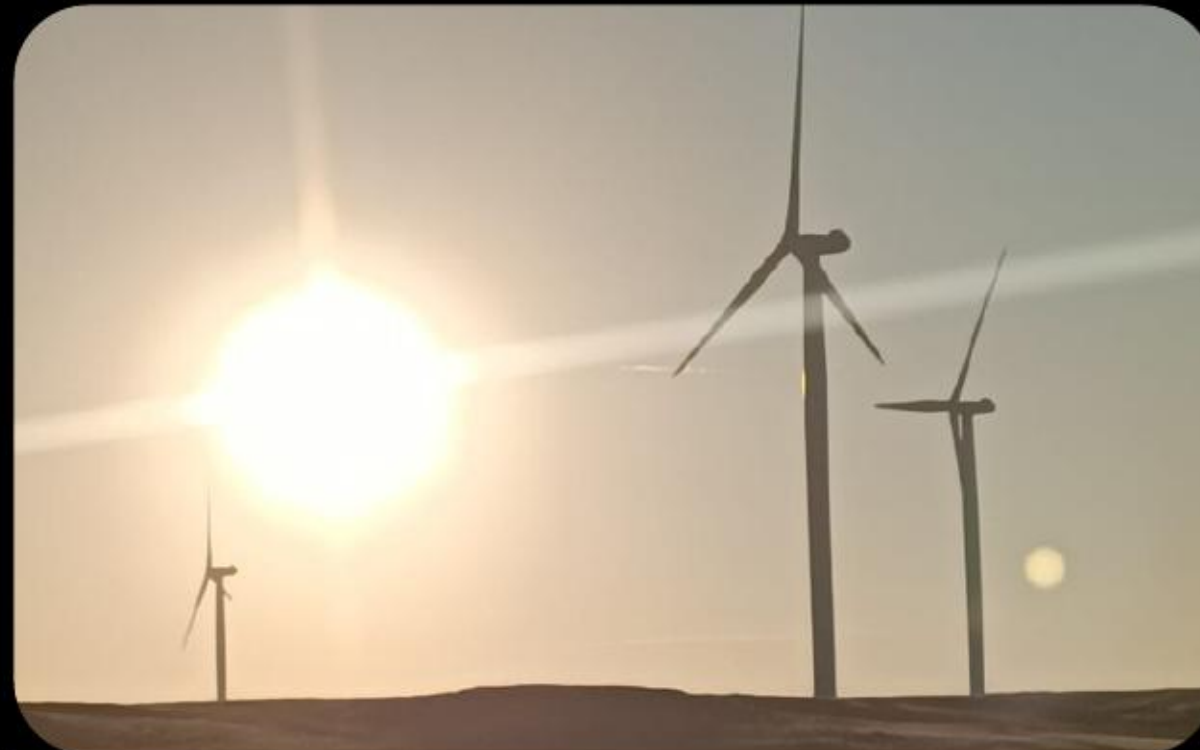
Instalaciones eléctricas e hidráulicas para apoyo en planta eólica
