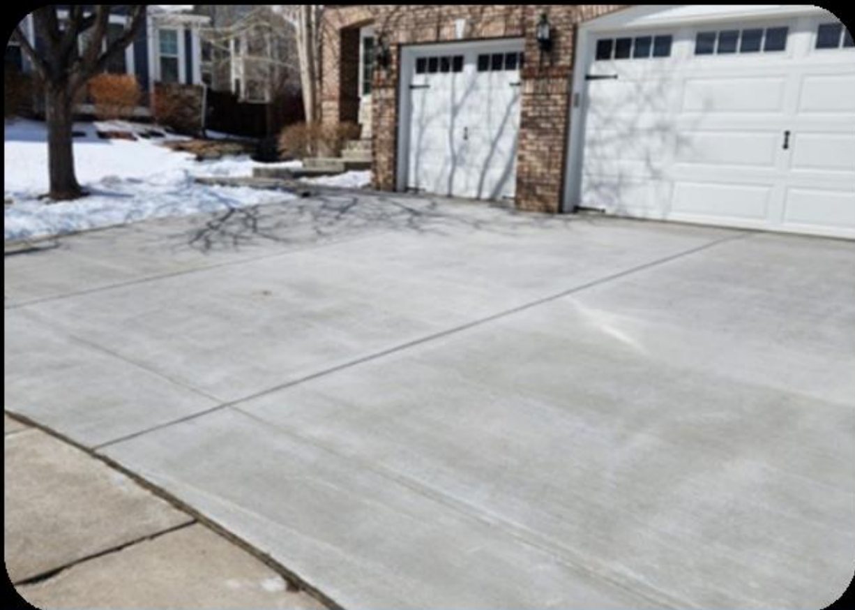
Colado de losa de concreto en acceso vehicular
