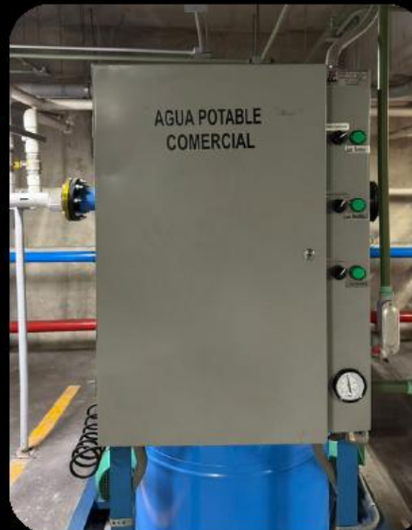
Sistema de bombeo automatizado para edificio de uso mixto
