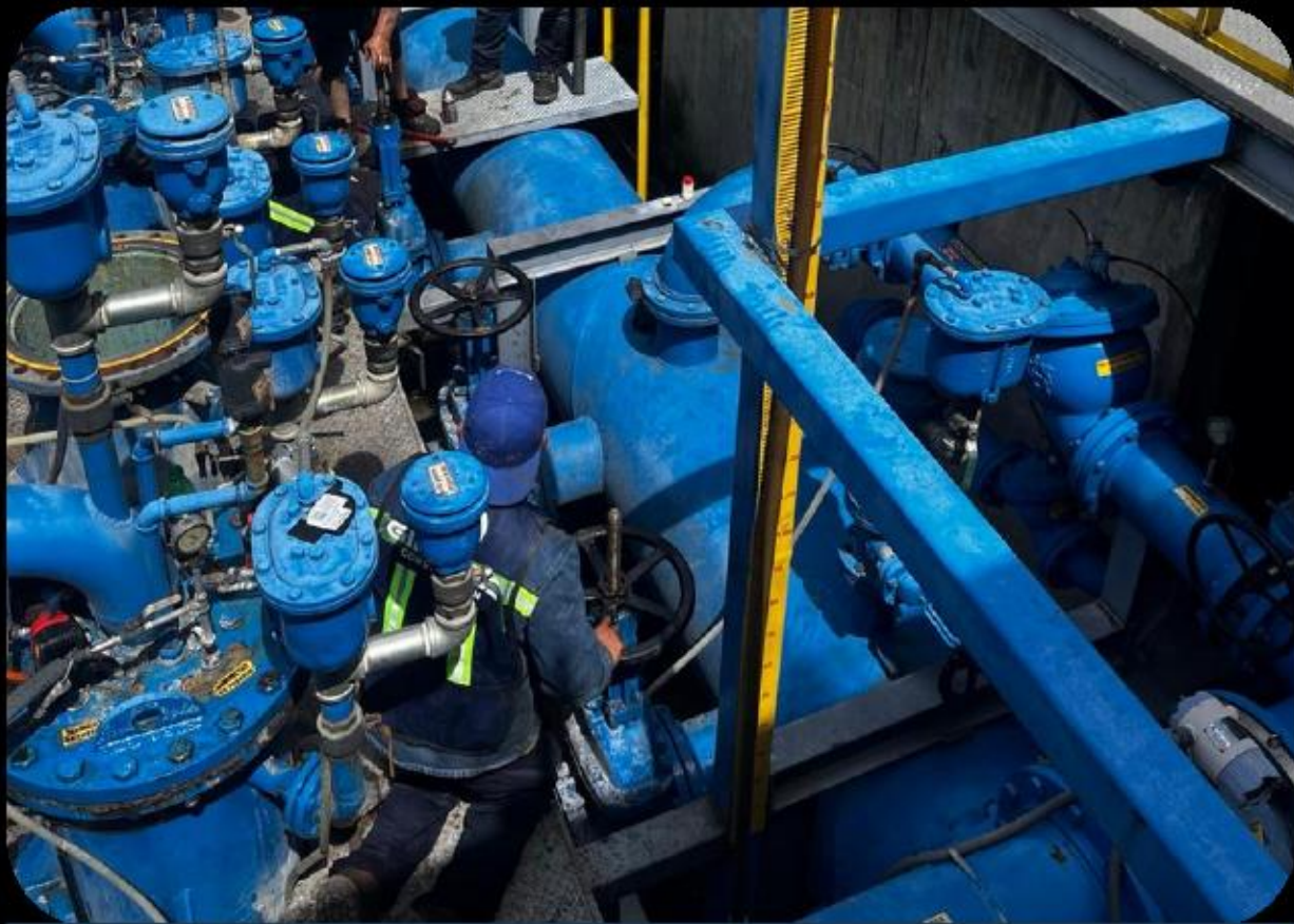
Mantenimiento de red hidráulica en cámara de válvulas
