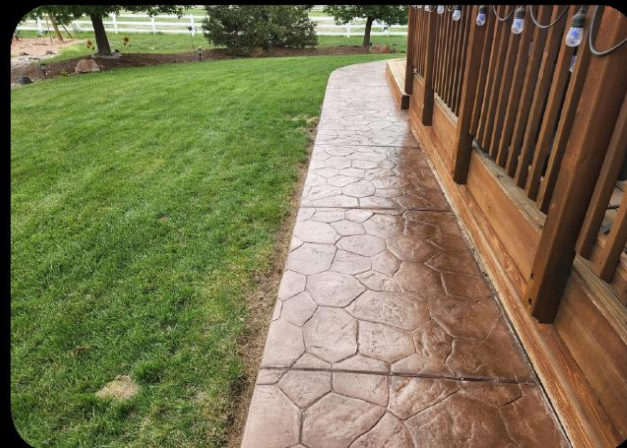
Detalle de acabado en concreto estampado en área exterior
