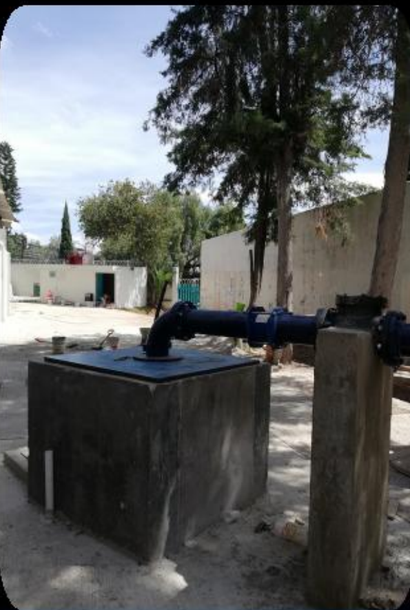
Construcción de tren de descarga para pozo de agua potable
