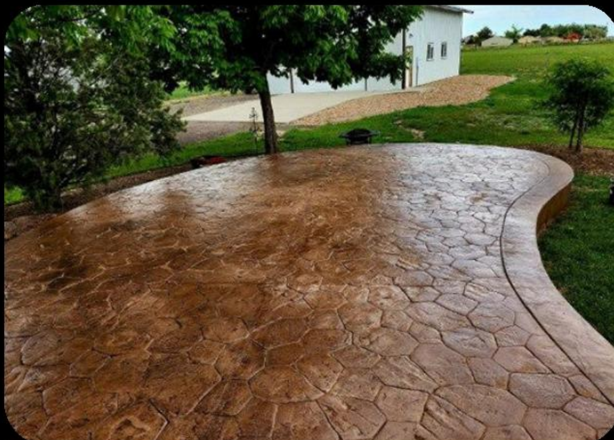
Aplicación de concreto estampado en área exterior
