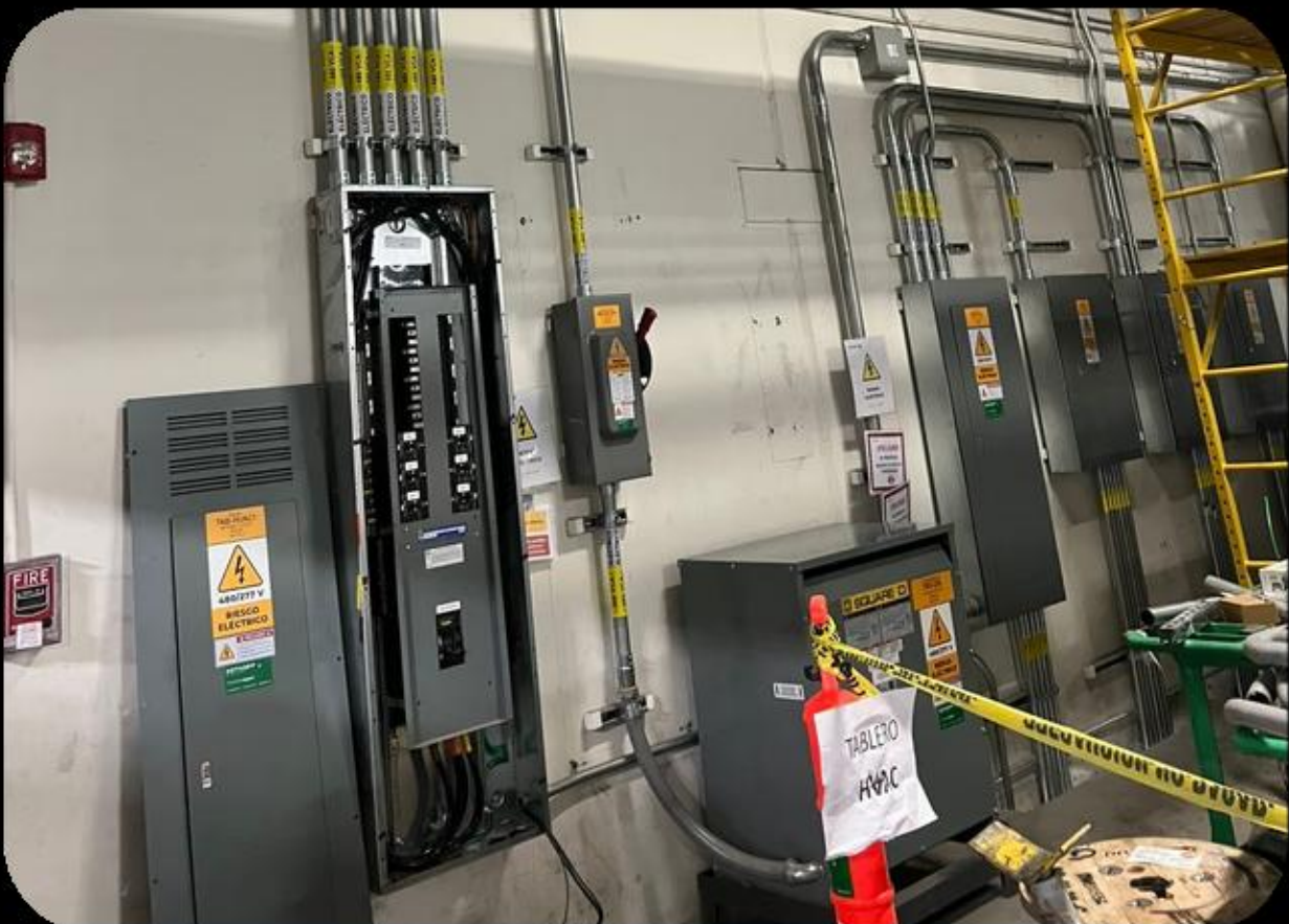
Instalación eléctrica y mecánica para cuarto limpio
