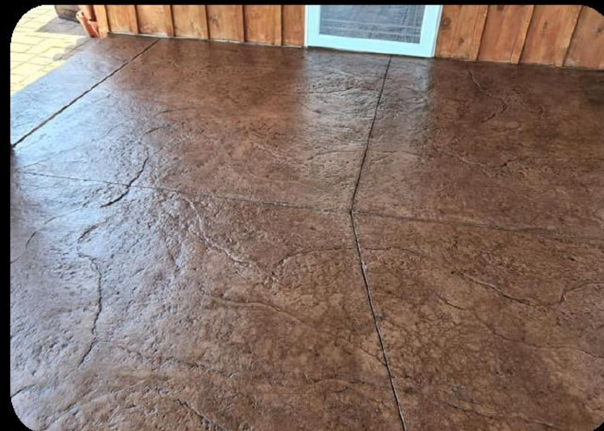
Detalle de acabado estampado en piso de concreto
