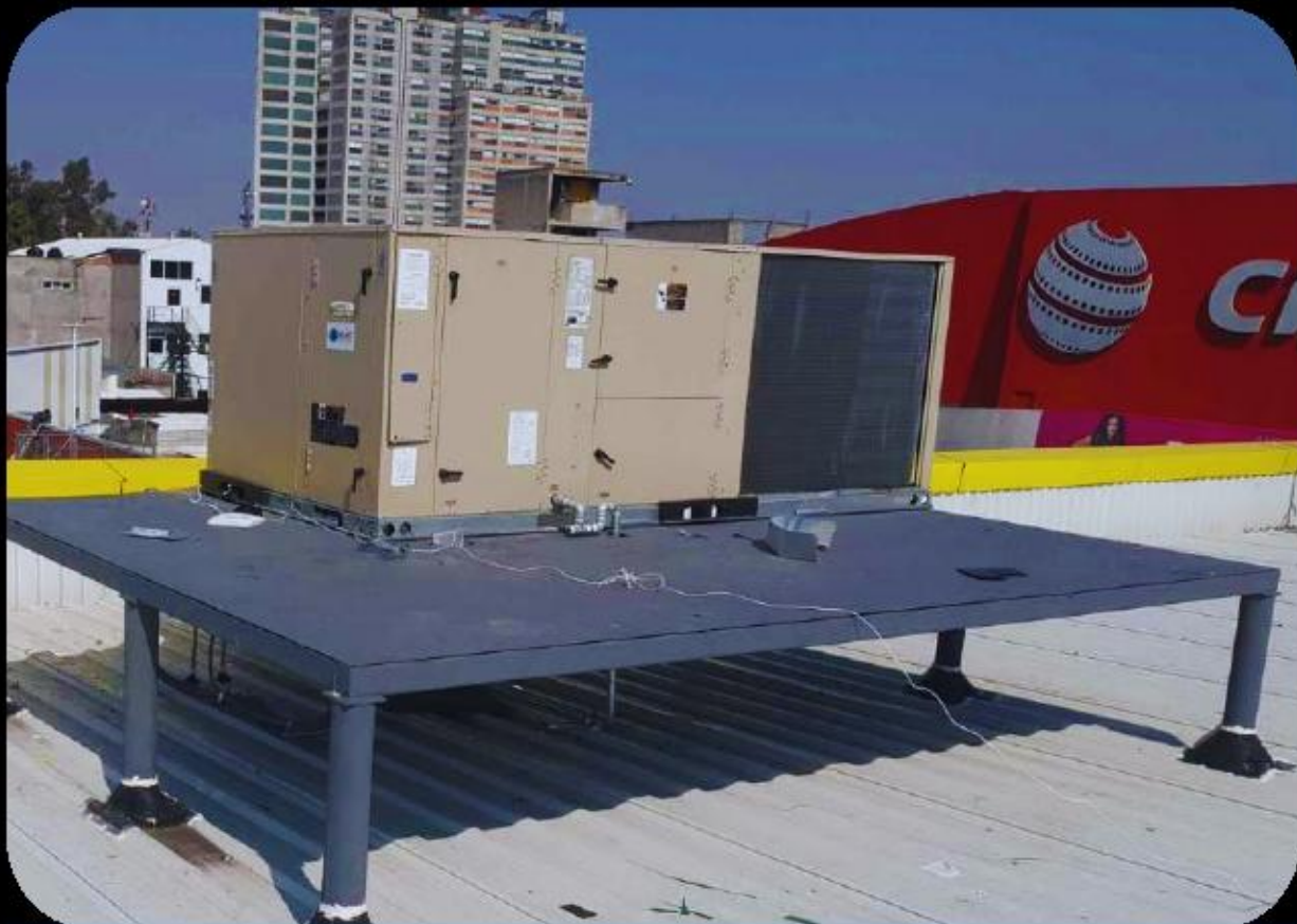
Instalación de unidad paquete tipo rooftop (HVAC) para climatización
