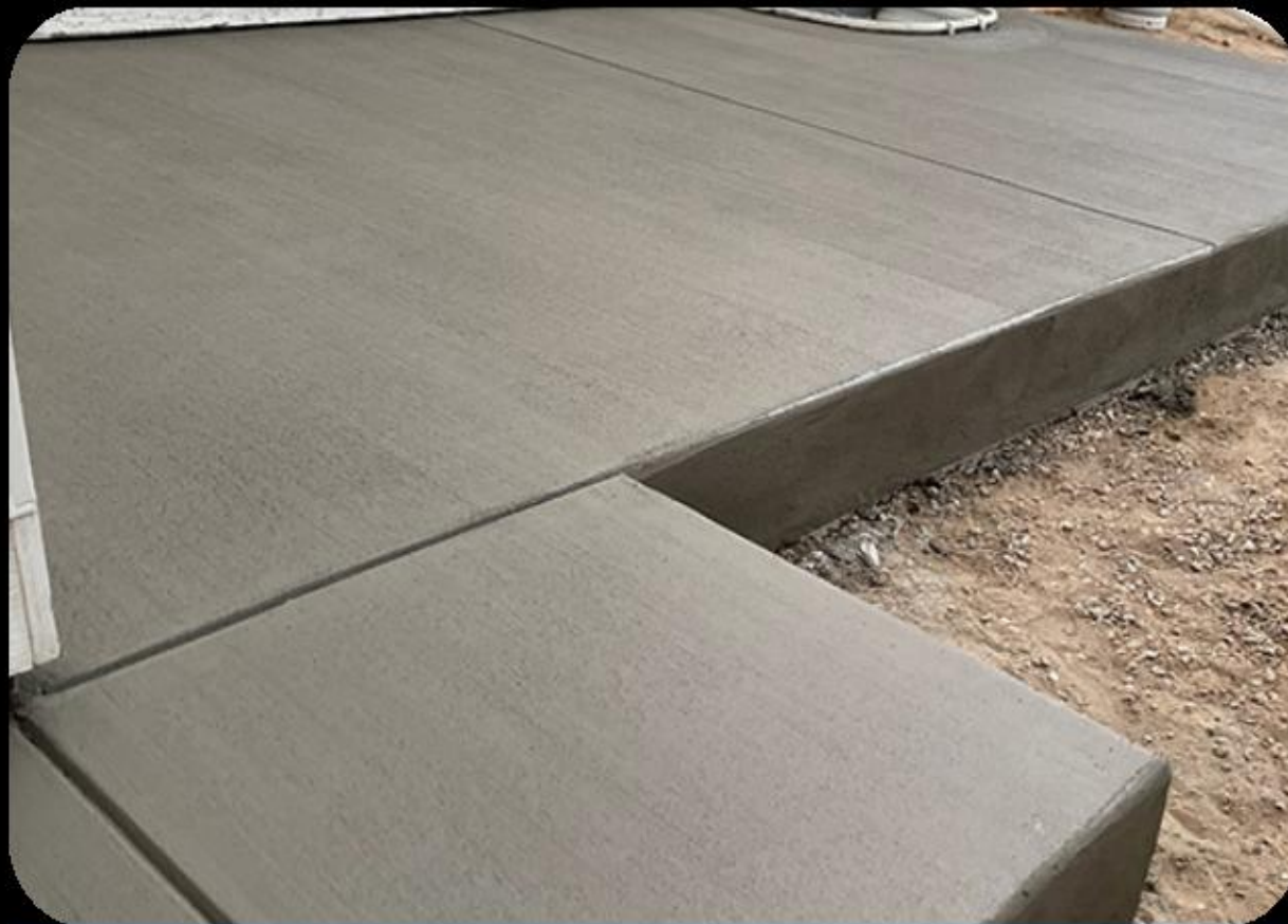
Ejecución de piso de concreto en patio de vivienda
