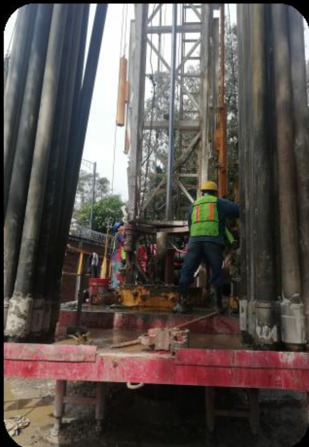
Perforación de pozo para abastecimiento de inmueble
