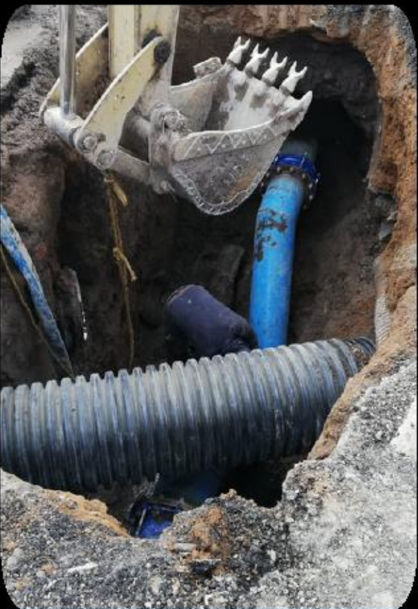
Instalación de bypass para red de agua potable
