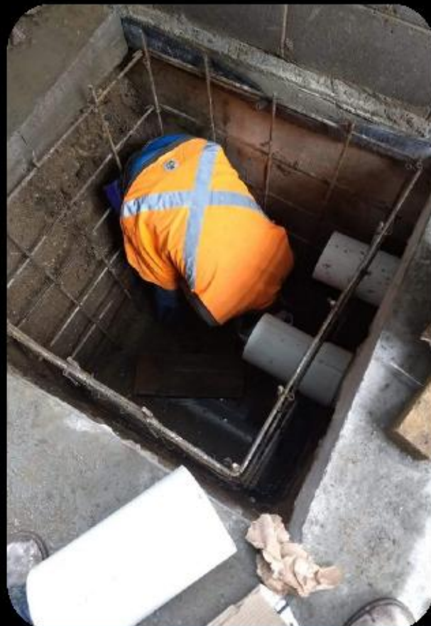
Intervención en registro hidráulico para mantenimiento y conexión
