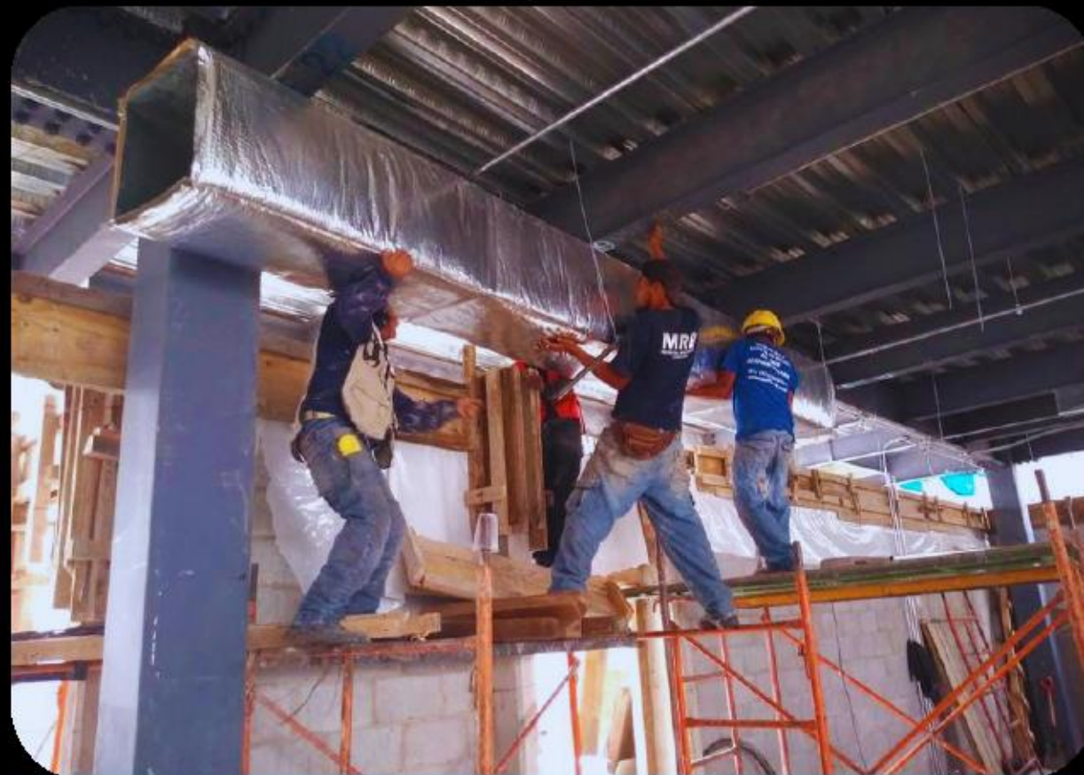
Montaje de ductos para distribución de aire en área interior
