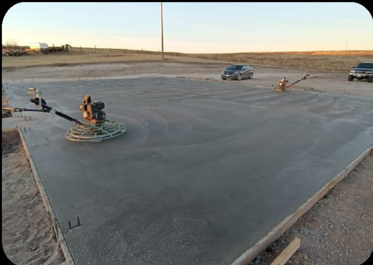
Colado de losa de concreto para desplante de estructura
