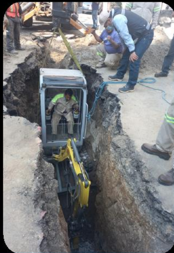
Ejecución de obra hidráulica para conducción de escurrimientos
