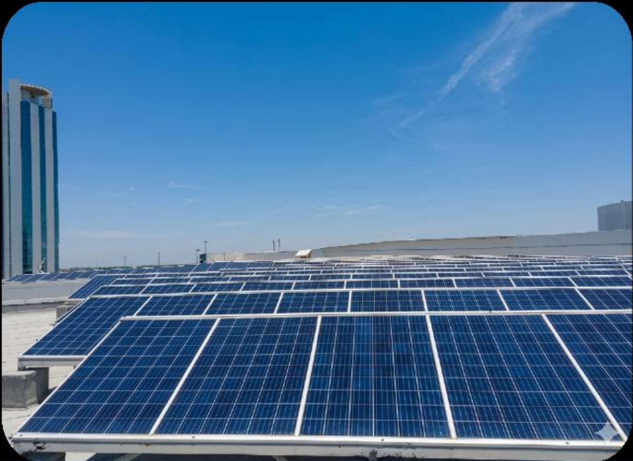
Mantenimiento de sistemas fotovoltaicos
