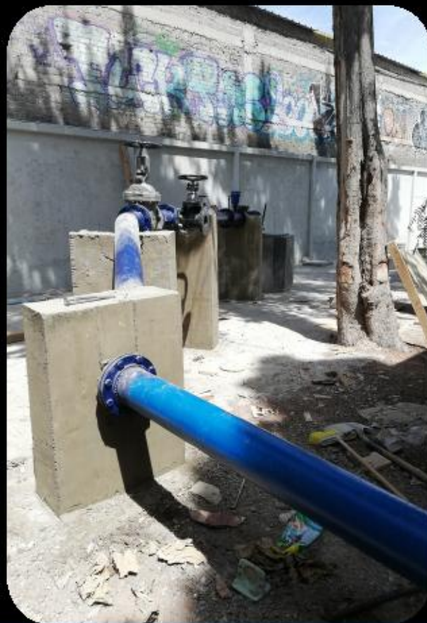
Construcción de tren de descarga para pozo de agua potable
