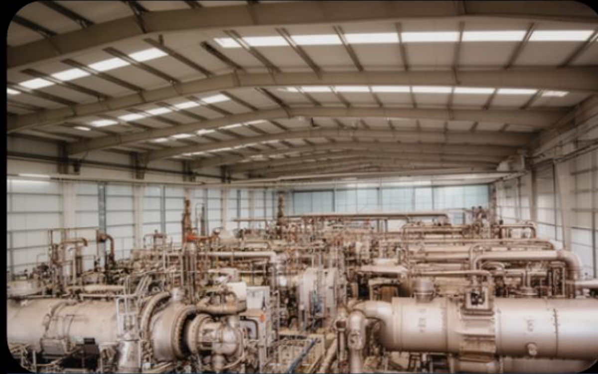
Mantenimiento correctivo a la red eléctrica en planta industrial
