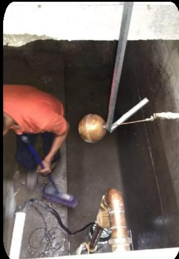
Intervención en registro hidráulico para mantenimiento y conexión
