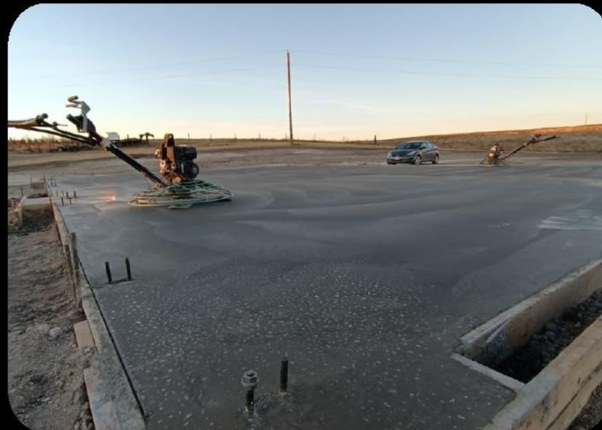
Losa de concreto con preparación para montaje de estructura
