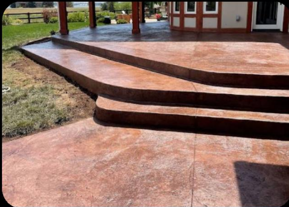
Ejecución de piso de concreto con acabado decorativo en área exterior
