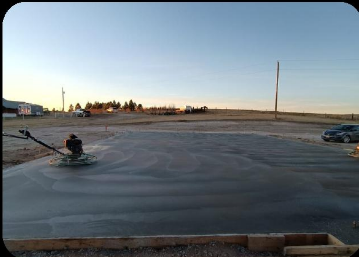
Acabado de losa de concreto con allanadora mecánica
