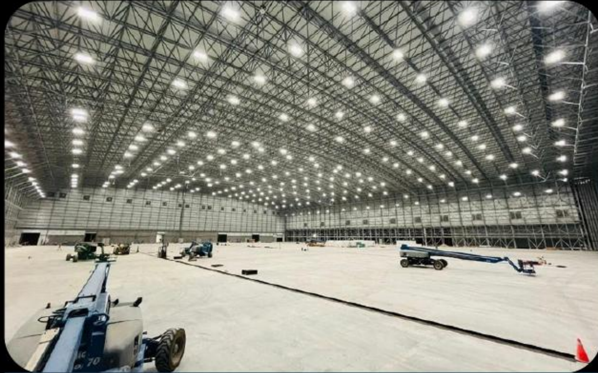
Instalación de infraestructura eléctrica en nave
