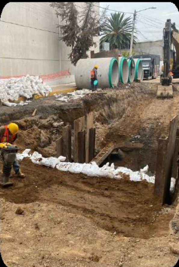
Excavación para instalación de tubería de escurrimientos
