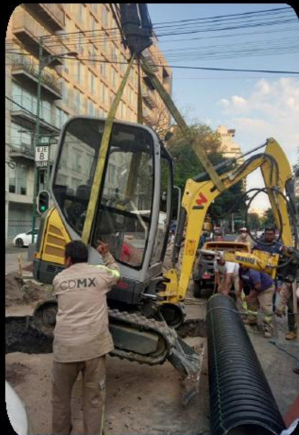
Ejecución de obra hidráulica para conducción de escurrimientos
