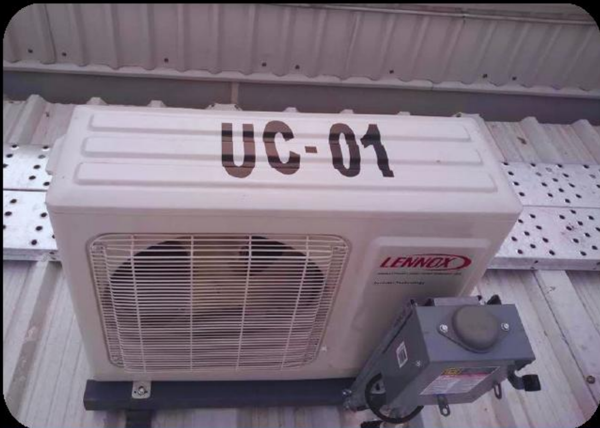
Instalación de unidad de aire acondicionado tipo minisplit
