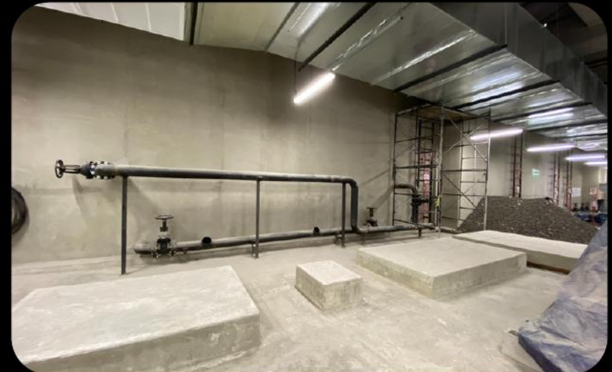
Instalación de redes hidráulicas en desarrollo vertical
