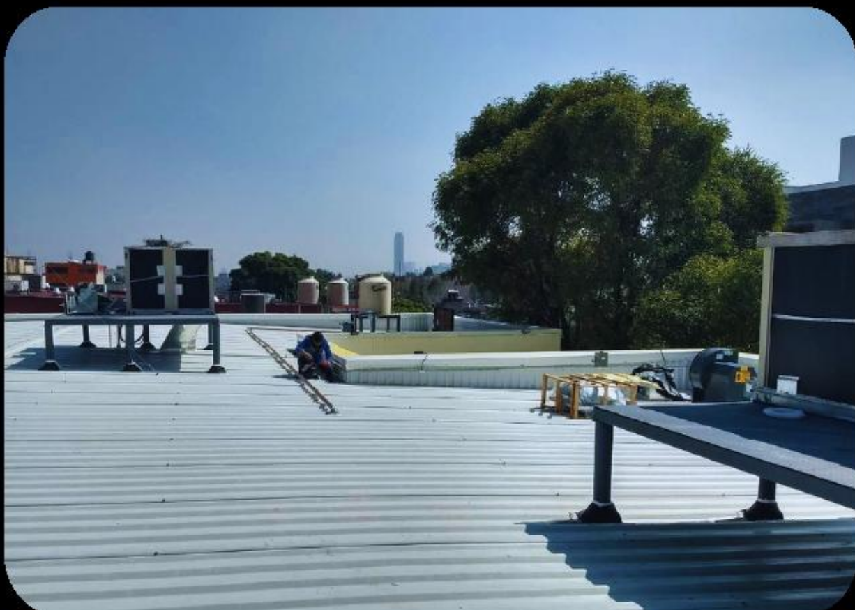
Implementación de sistema de climatización tipo rooftop en cubierta
