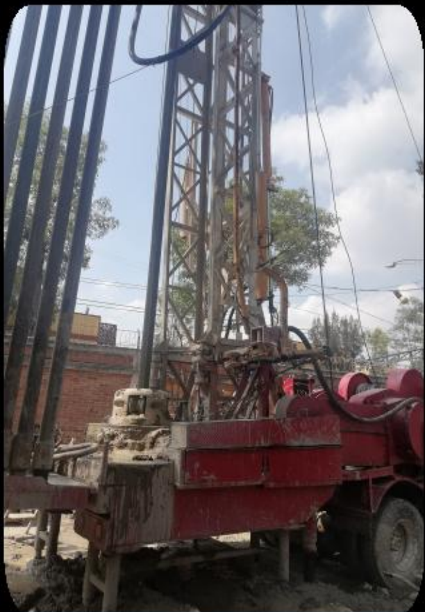
Perforación de pozo para abastecimiento de inmueble
