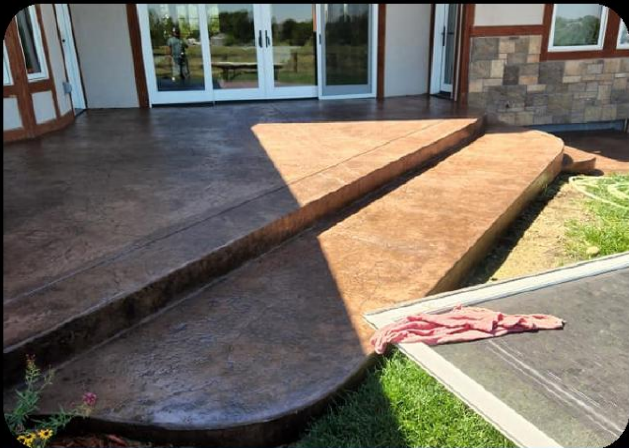
Ejecución de acceso exterior con concreto estampado
