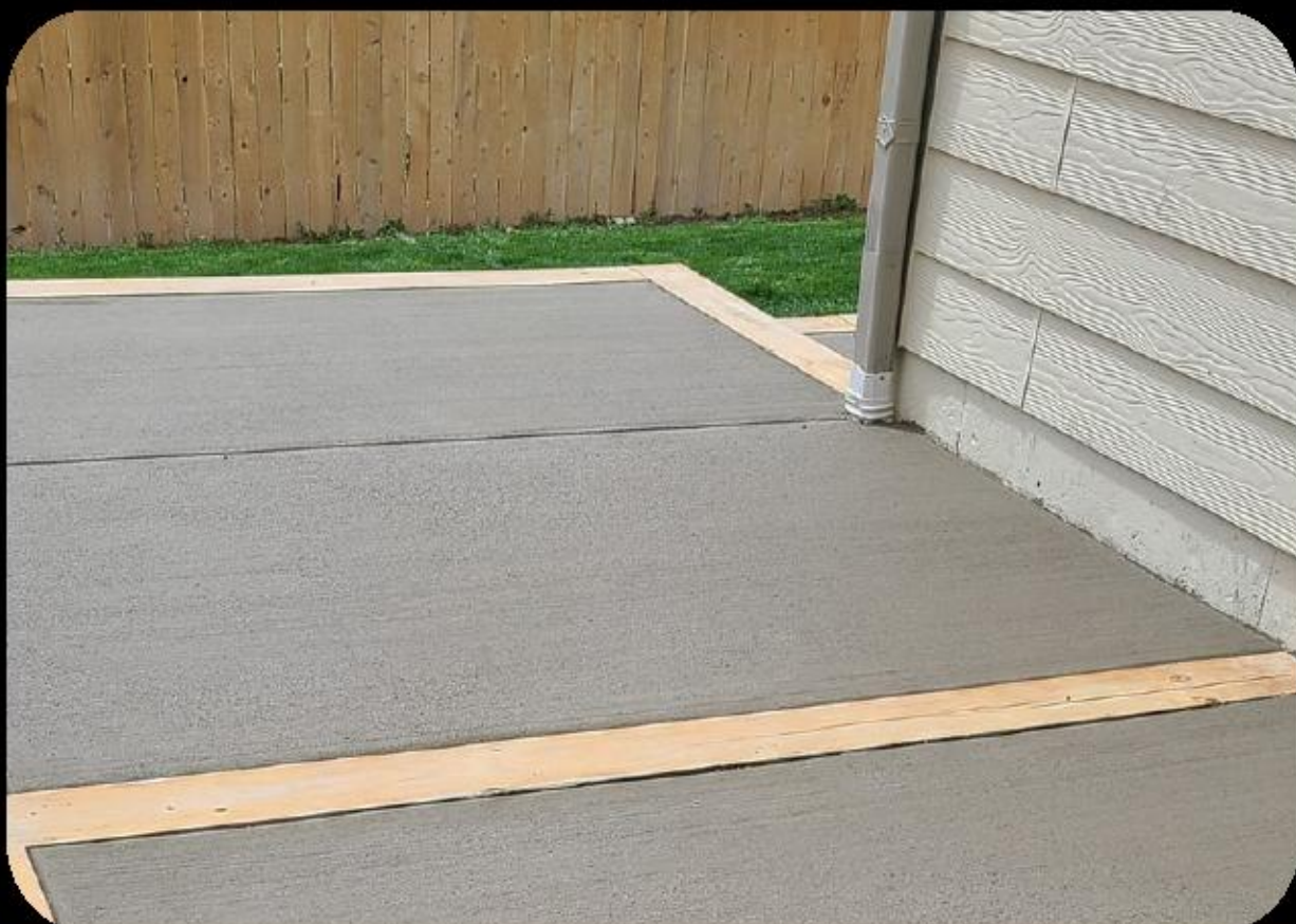
Colado de losa de concreto en área exterior
