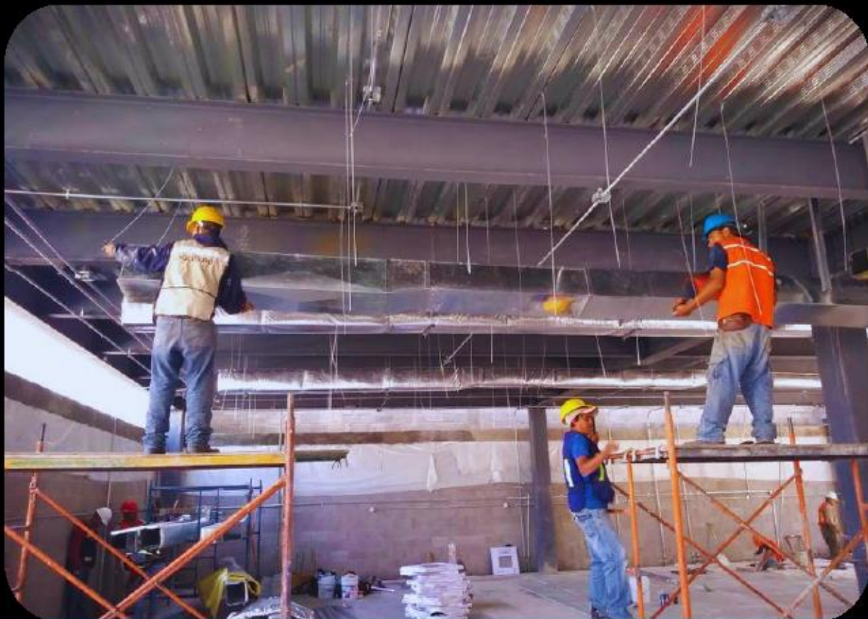
Instalación de ductería para sistema de aire acondicionado
