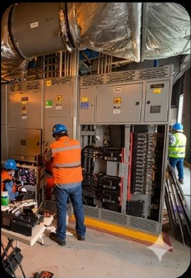
Mantenimiento a subestaciones y tableros autosoportados
