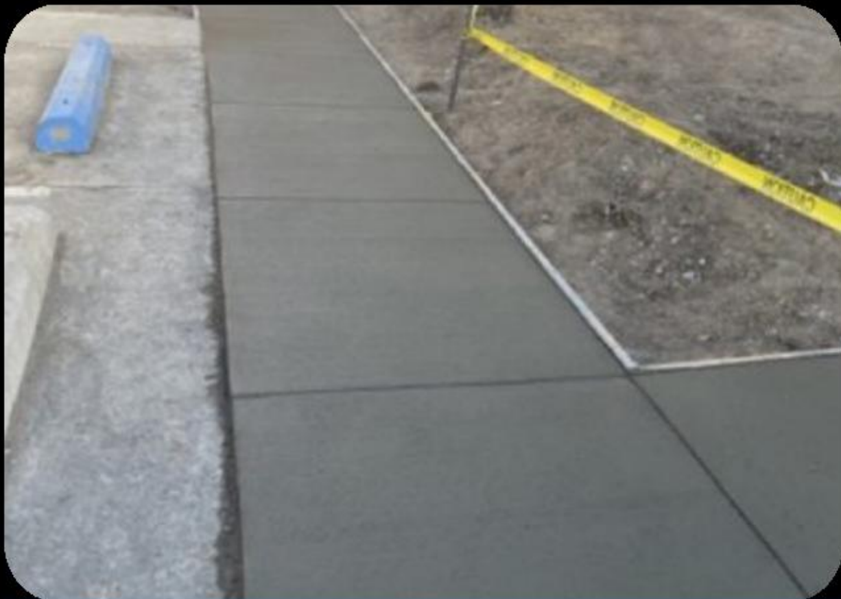
Construcción de banqueta de concreto en entorno urbano
