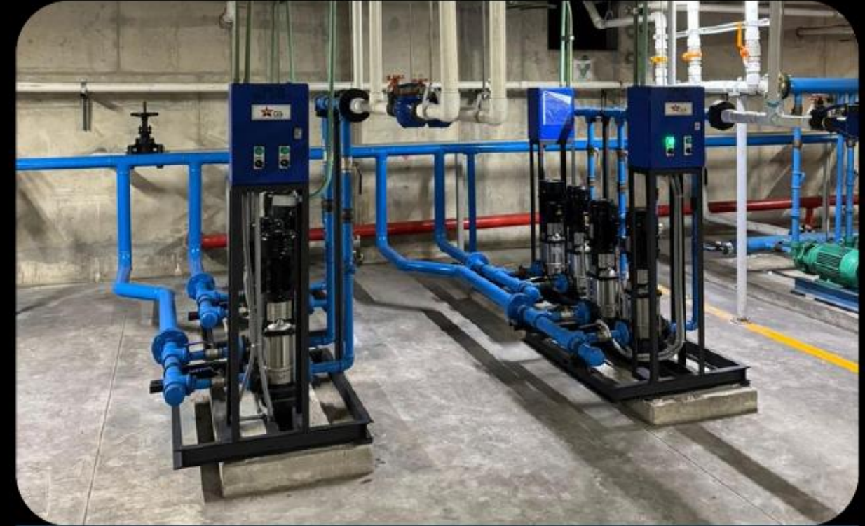
Mantenimiento a sistema de bombeo en edificio de uso mixto
