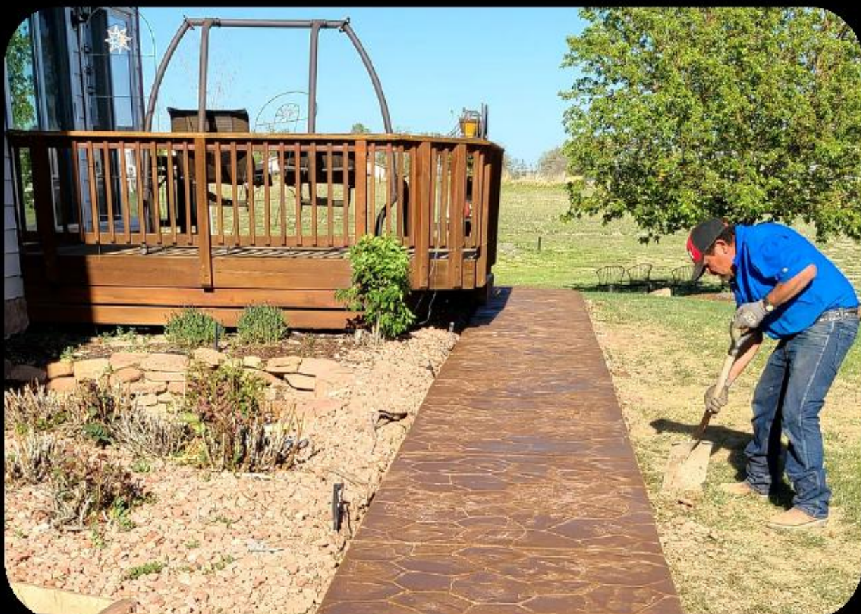
Ejecución de andador con concreto estampado
