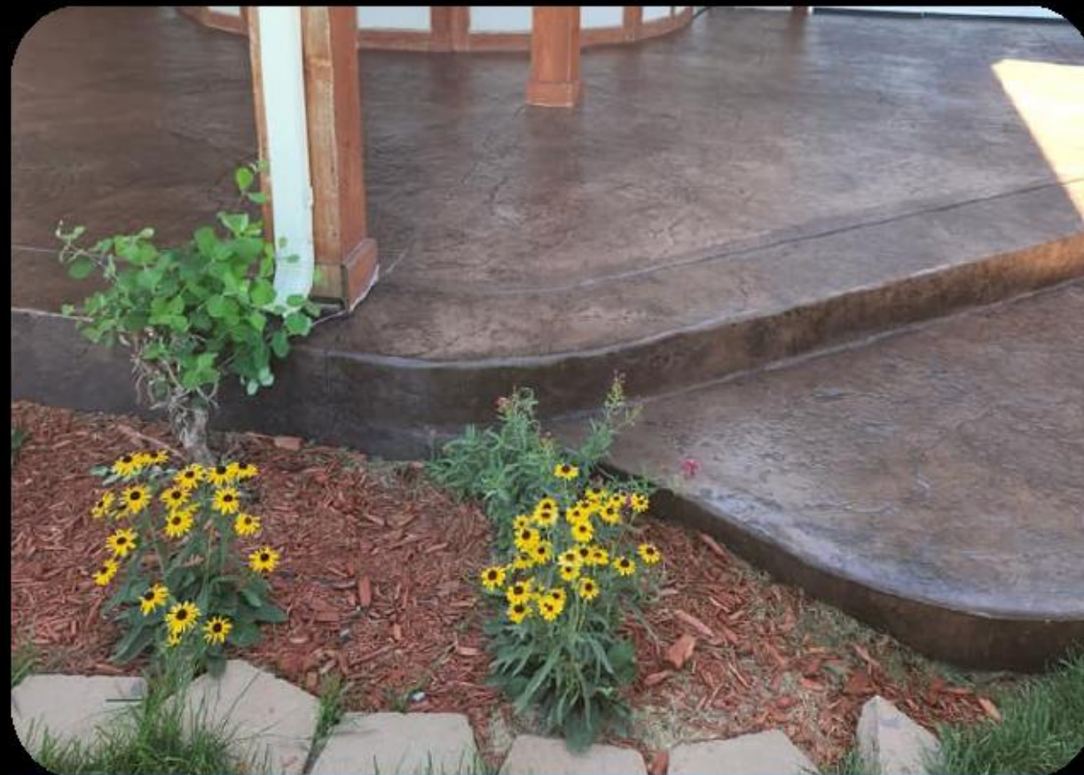
Acabado estampado en terraza de concreto
