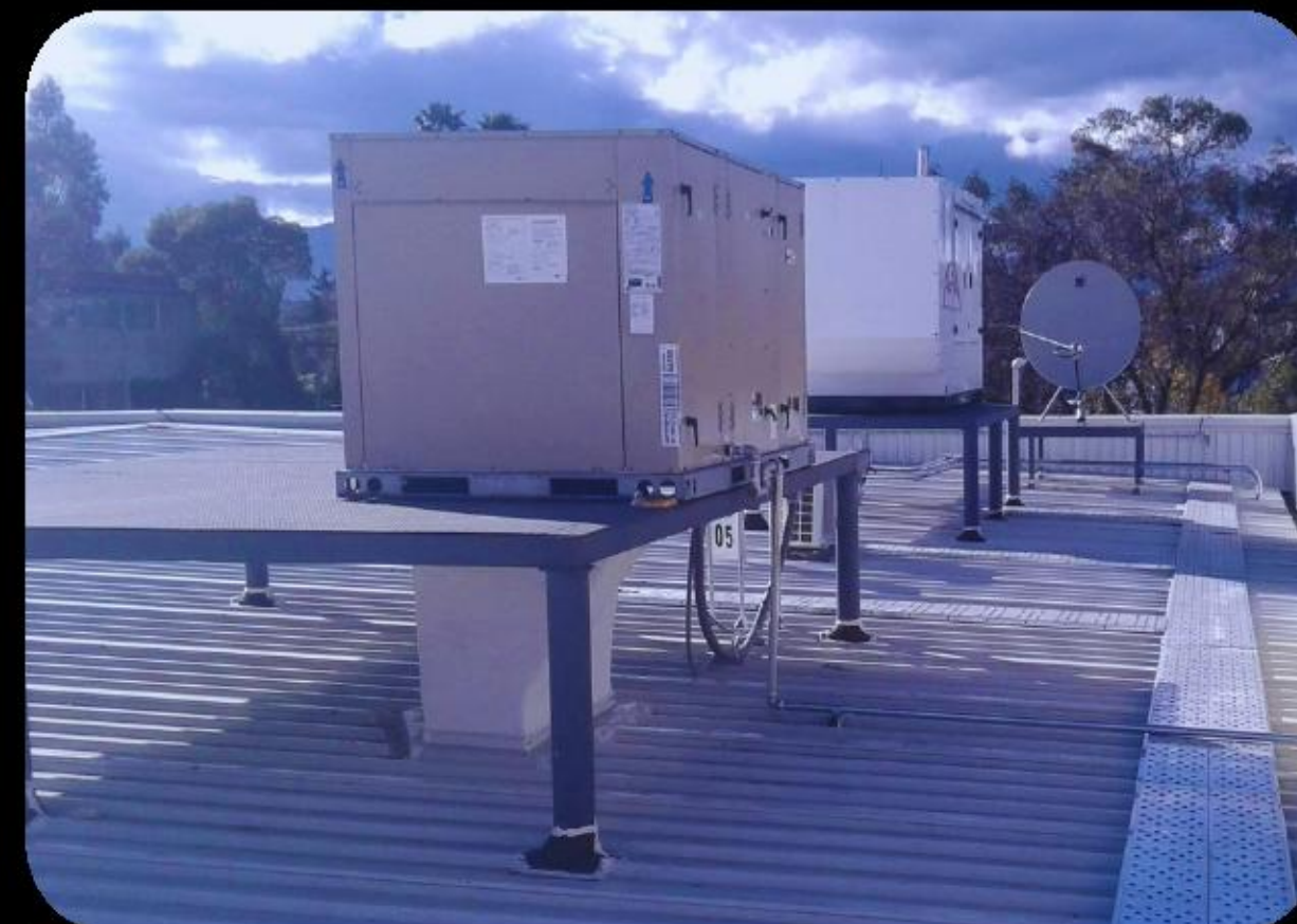
Montaje y puesta en operación de unidad paquete tipo rooftop (HVAC)
