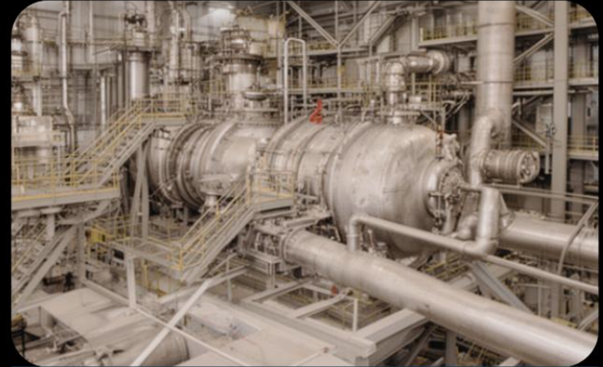
Mantenimiento y adecuación de instalaciones eléctricas en operación
