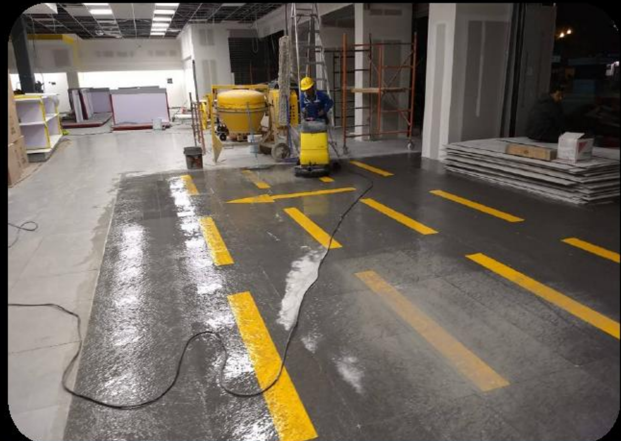
Limpieza y preparación de área y piso epóxico para entrega operativa
