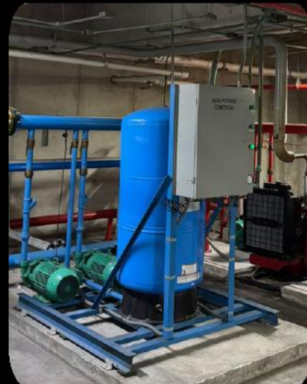
Sistema de bombeo automatizado para edificio de uso mixto
