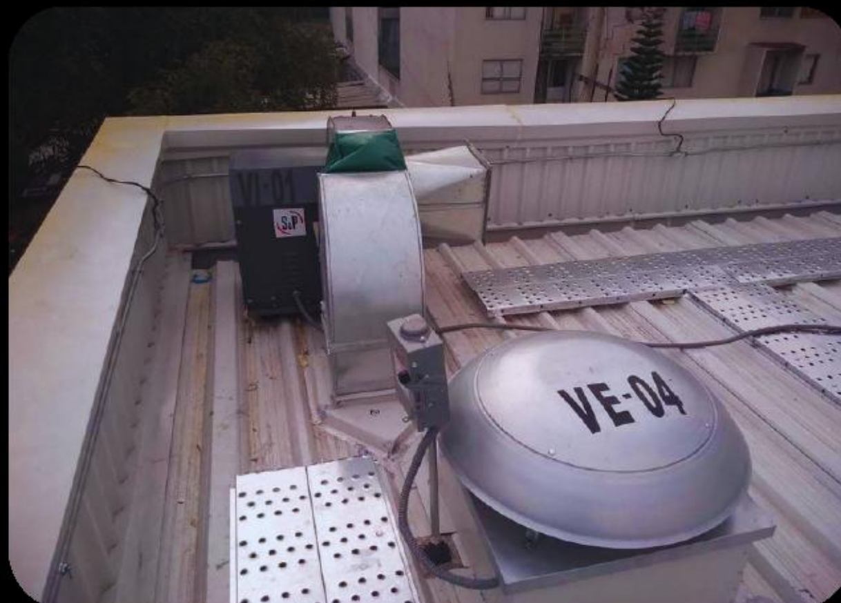
Instalación de sistema de extracción y ventilación mecánica
