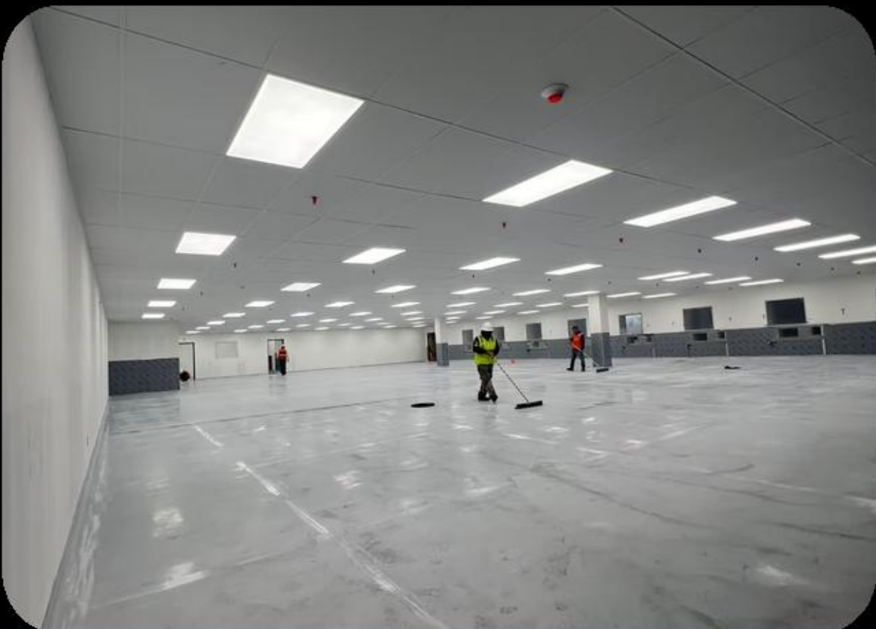
Adecuación de cuarto limpio
