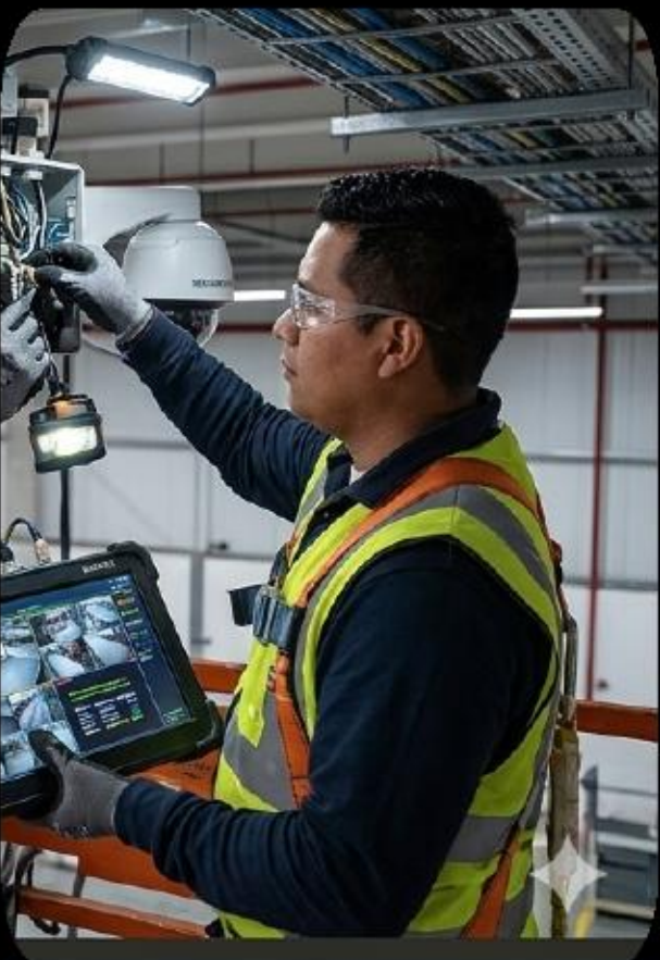
Instalación y puesta en marcha de circuitos CCTV
