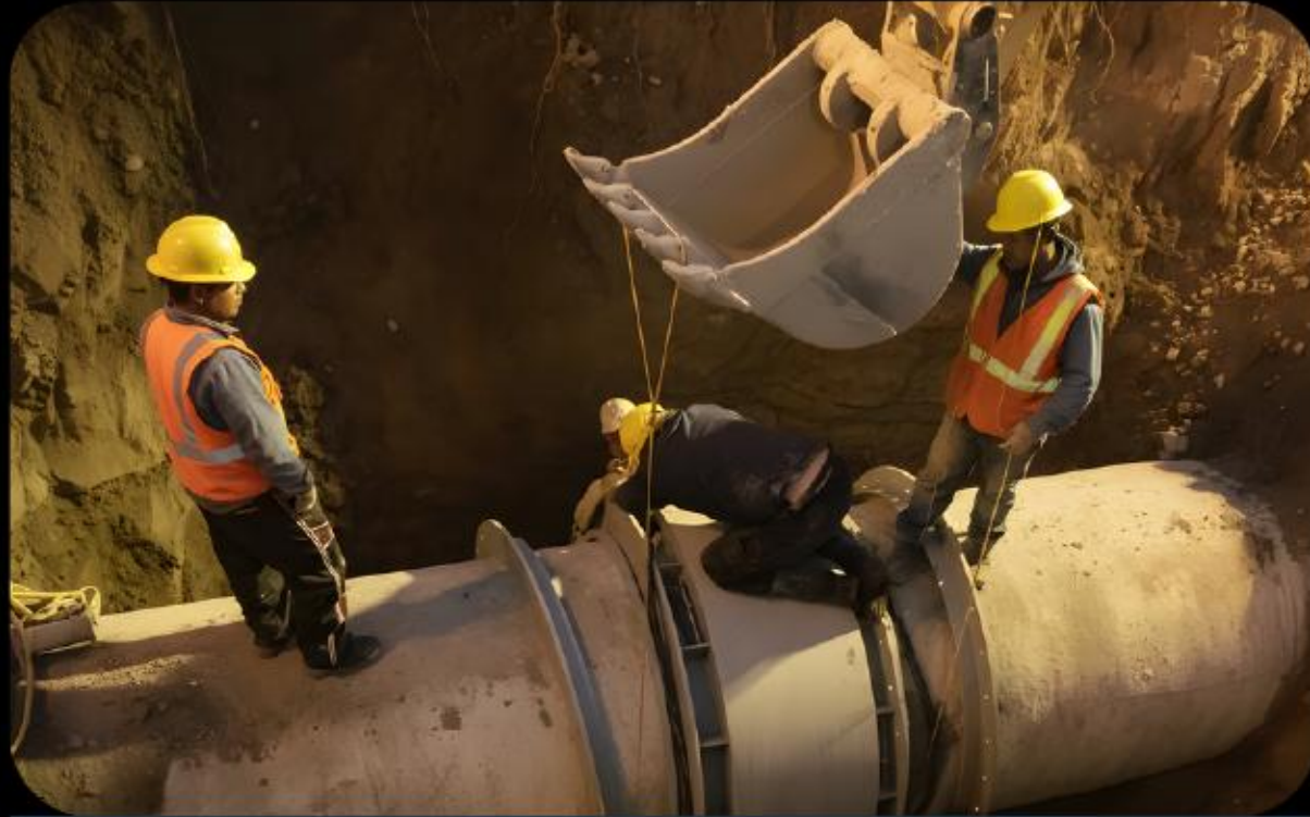
Instalación de redes y estructuras hidráulicas
