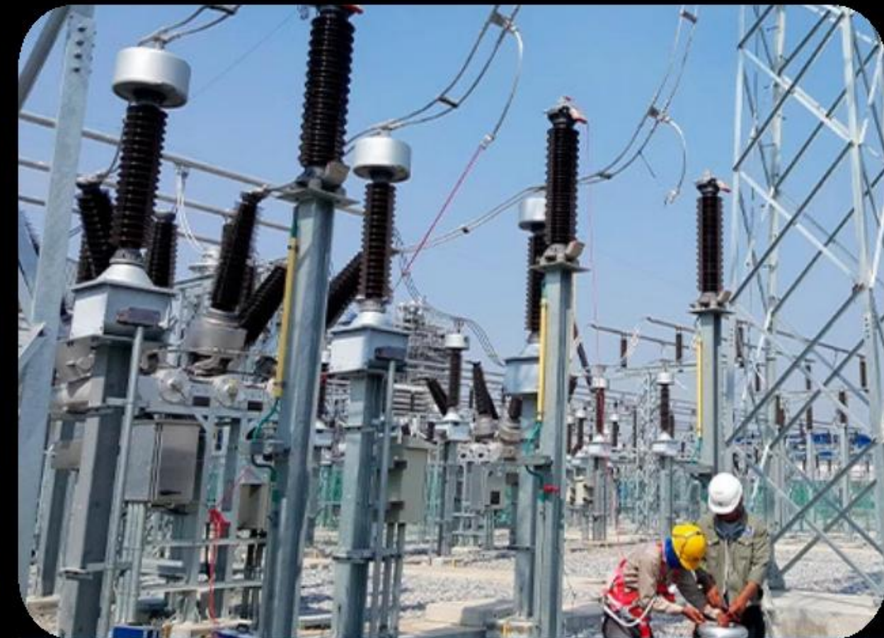
Reparaciones en subestación eléctrica
