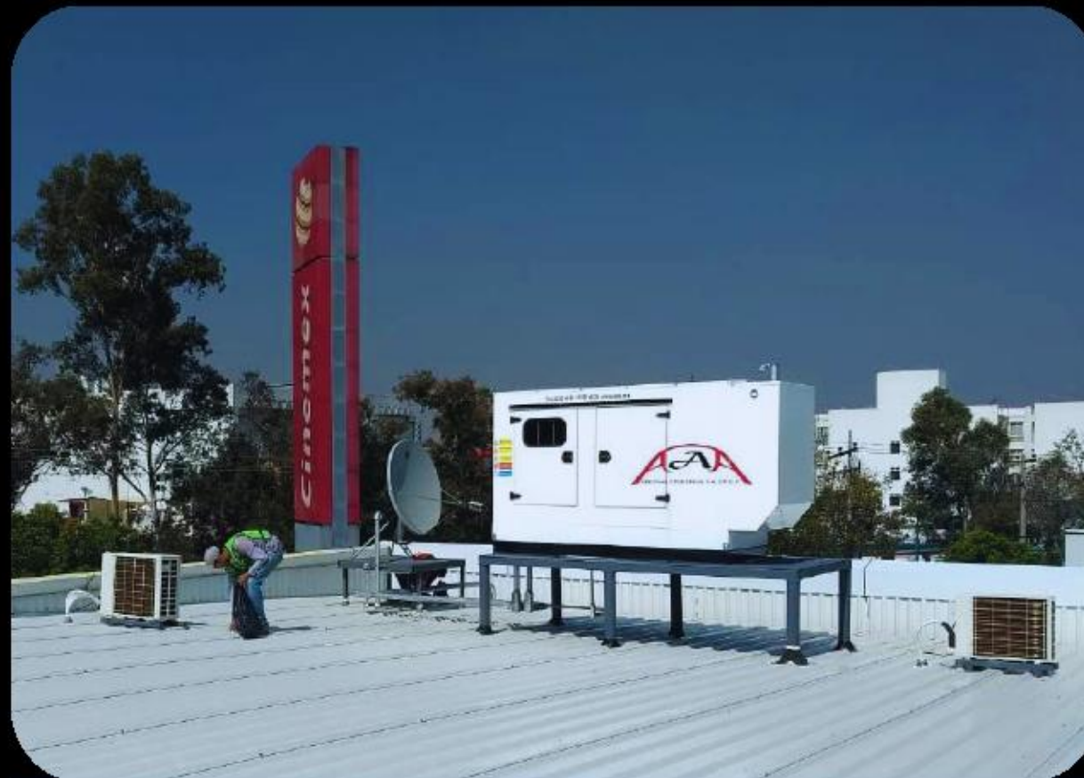
Instalación de planta de emergencia para respaldo eléctrico
